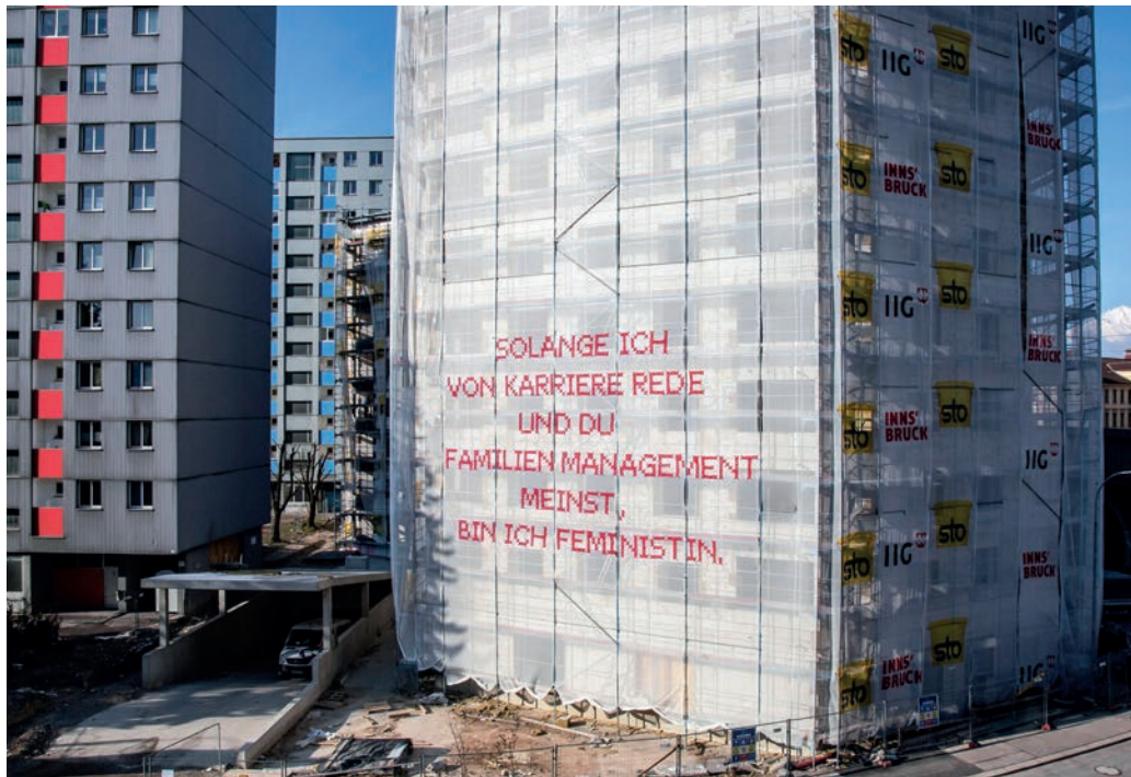
Baustelle #1: Bienerstraße, Innsbruck, AT, 2018
