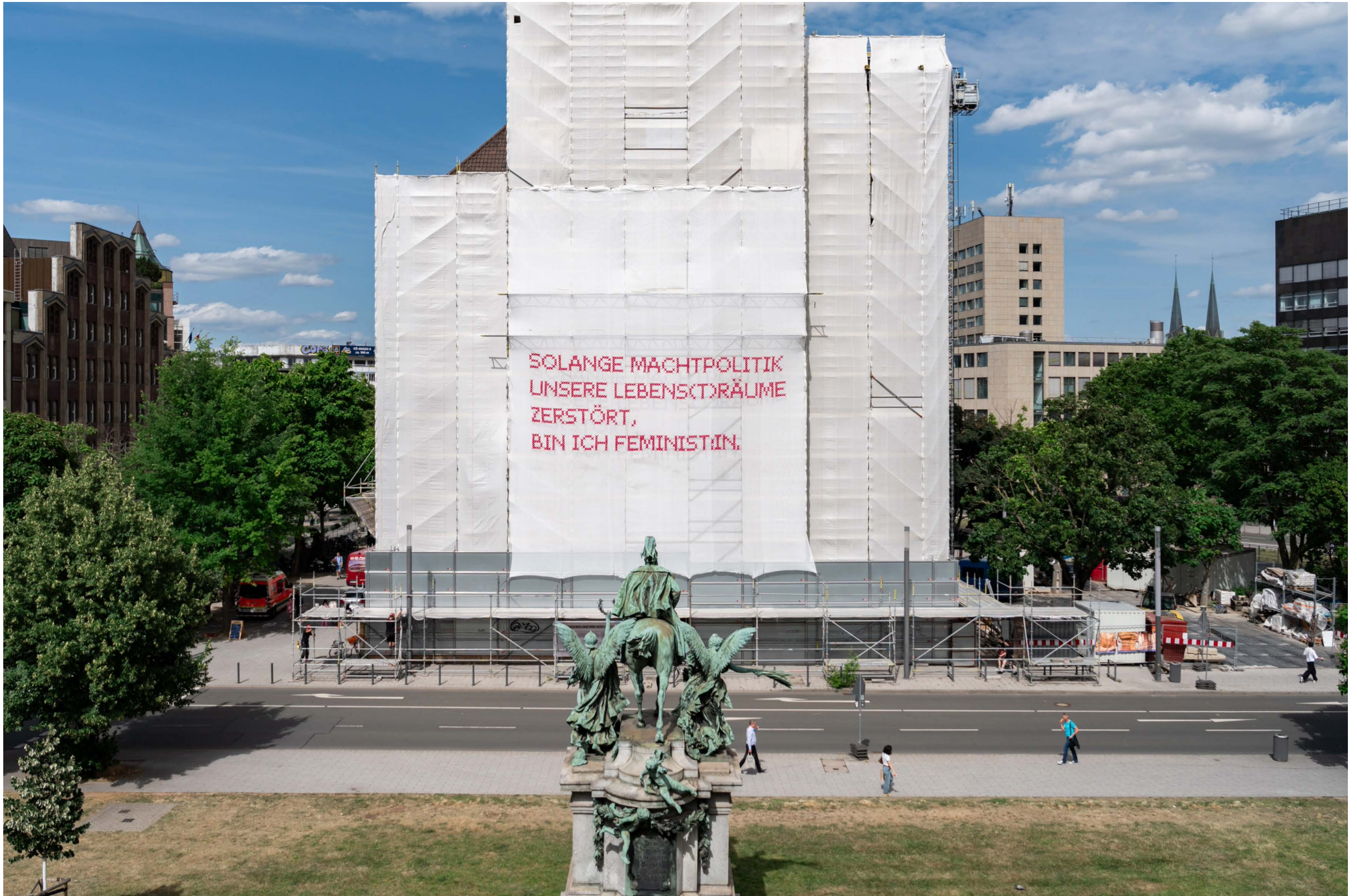
Baustelle #33: Johanneskirche Düsseldorf, DE, 2025
