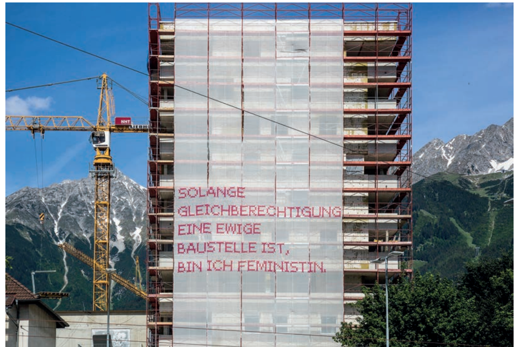
Baustelle #3: Reichenauerstraße, Innsbruck, AT, 2018-2020
