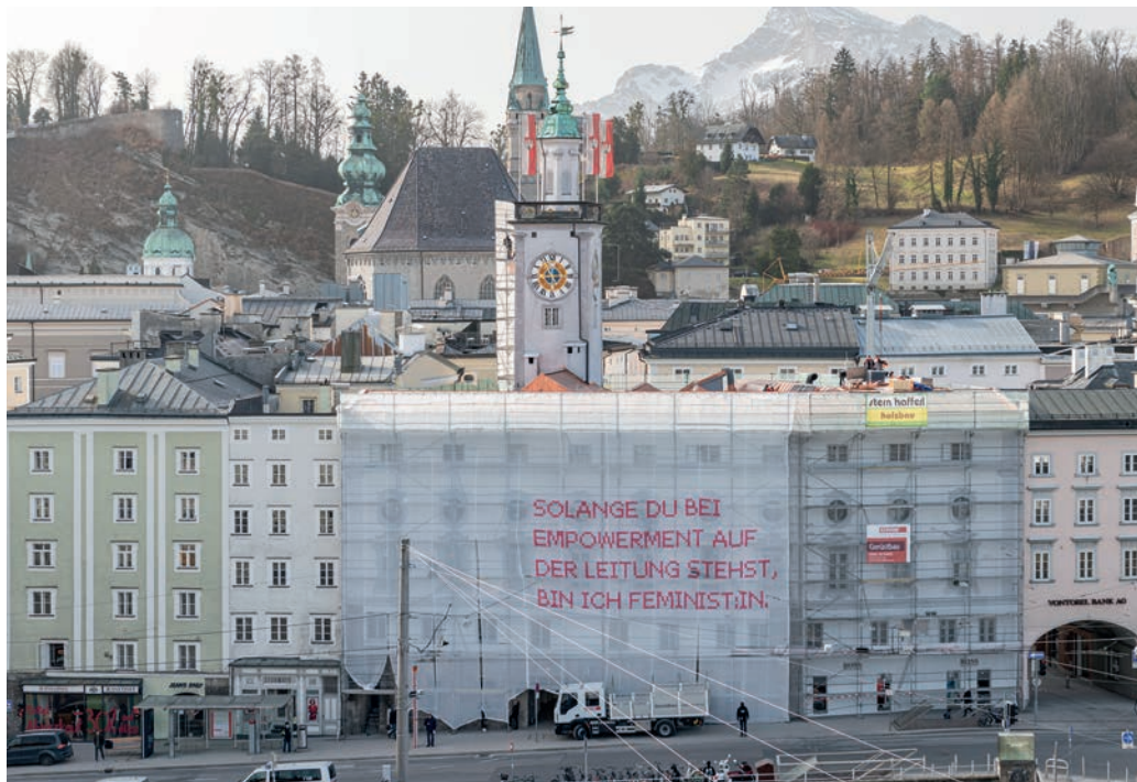
Baustelle #15: Altes Rathaus Salzburg, AT, 2021
