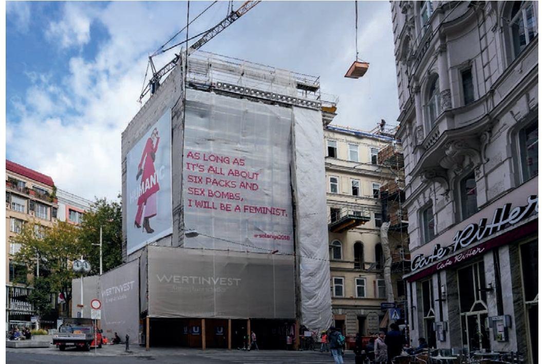
Baustelle #9: Hotel Kummer, Wien, Mariahilferstraße, 2019/2020
