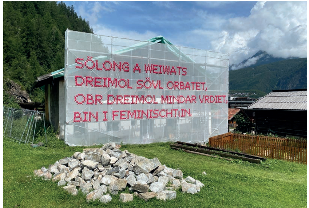
Baustelle #25: Wastls-Haus, Ötztaler Heimat- und Freilichtmuseum, AT, 2022/2023
