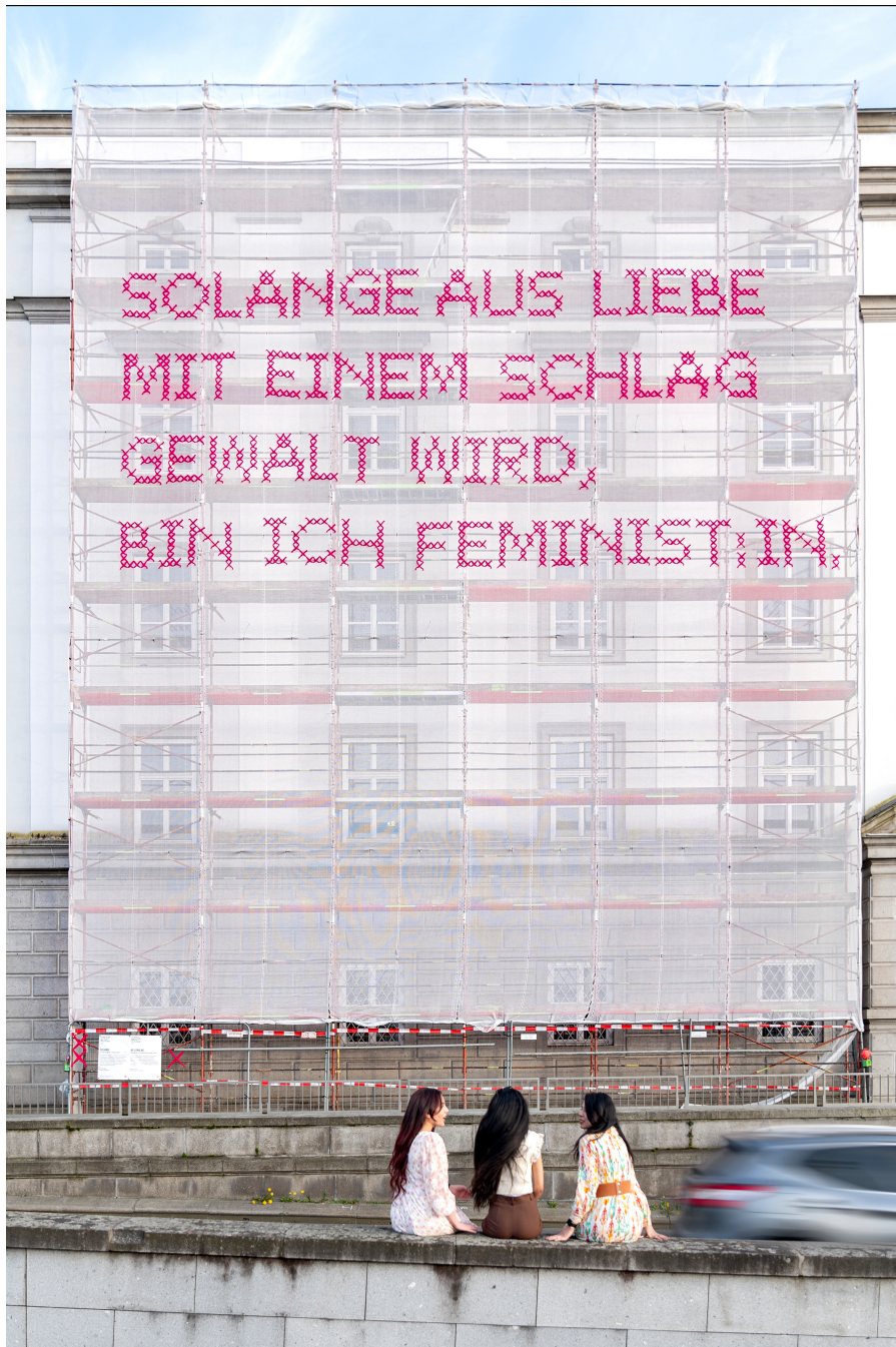
Baustelle #28: Kunstuniversität Linz, AT, 2023
