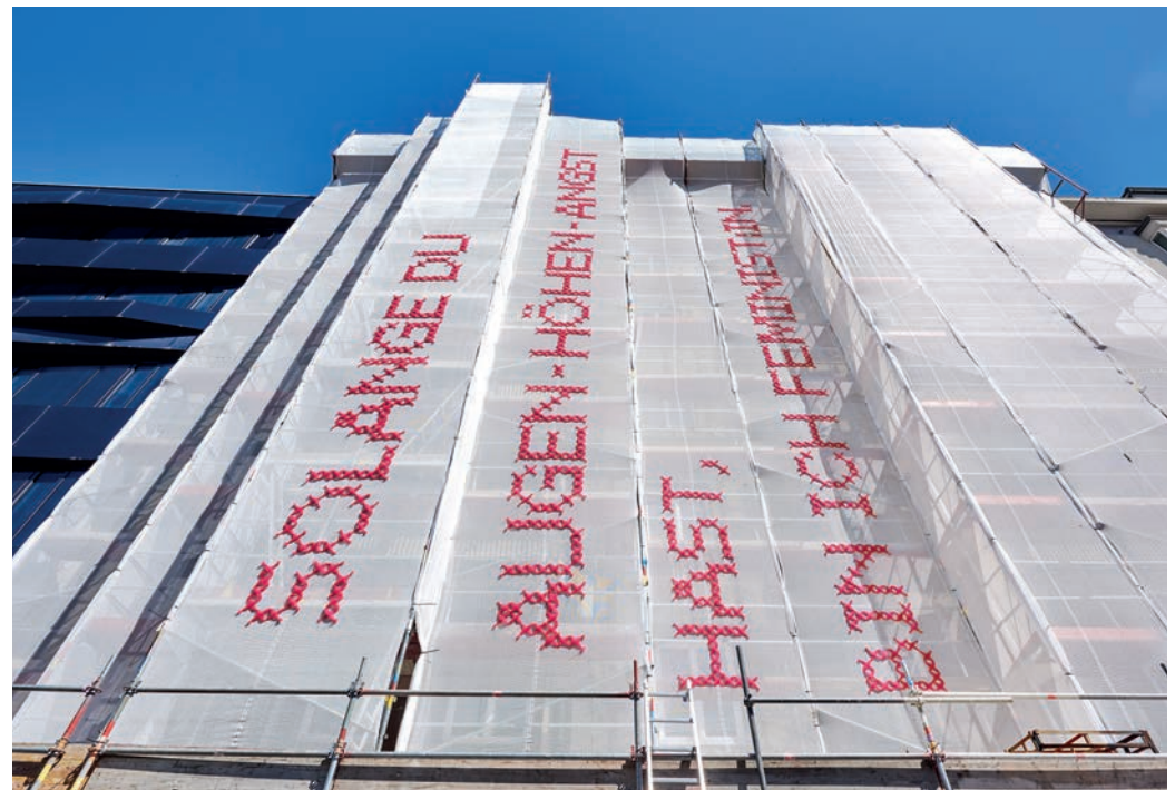
Baustelle #12: Linke Wienzeile 168, Wien, AT, 2020
