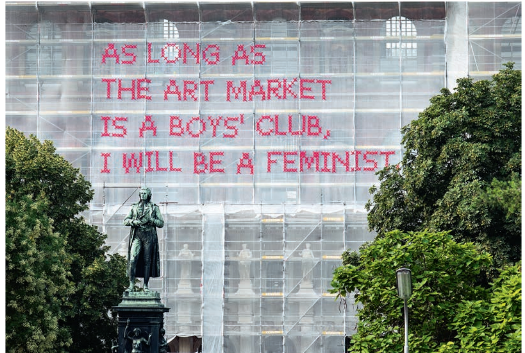
Baustelle #4: Akademie der Bildenden Künste Wien, AT, 2018-2020
