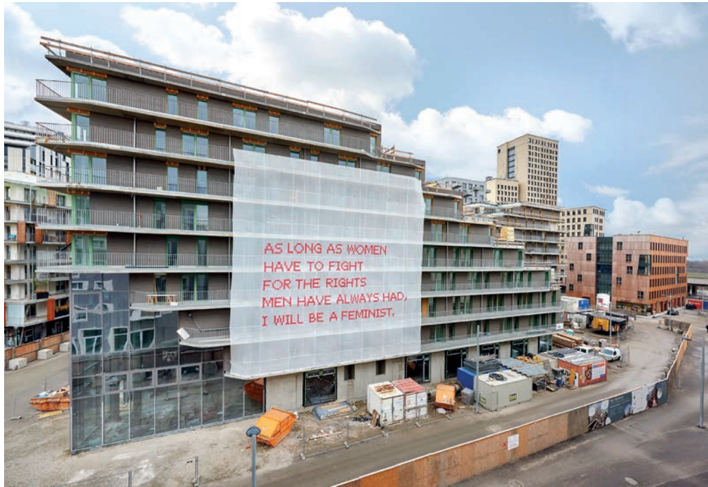
Baustelle #10: Seestadt ASPERN, Wien, 2019/2020
