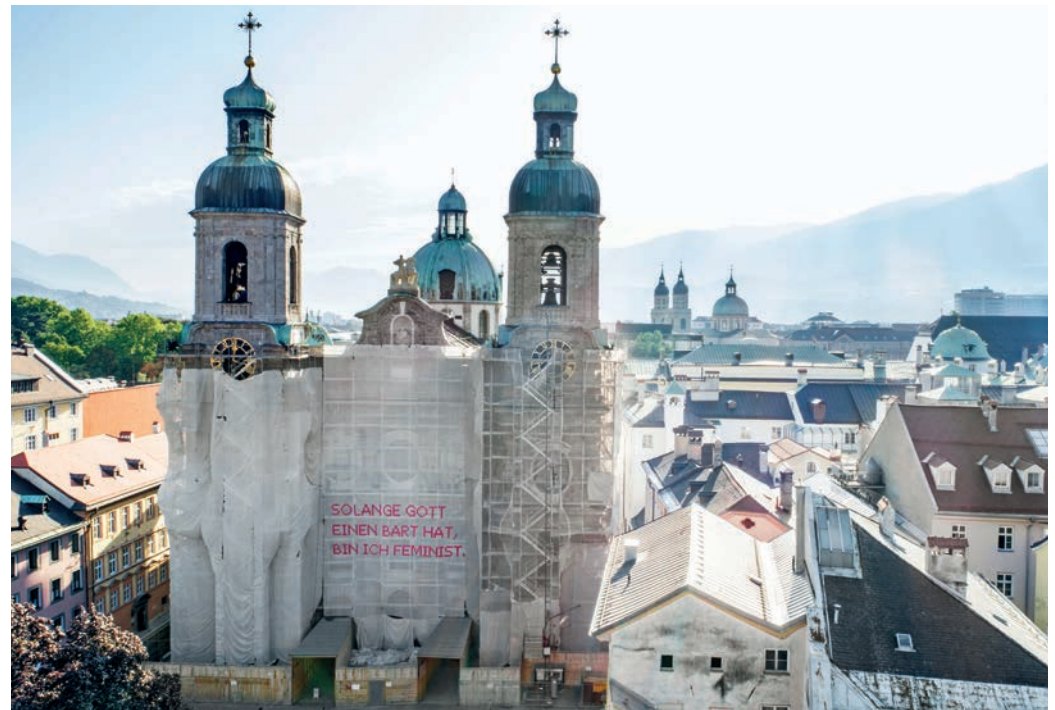
Baustelle #5: Dom zu St. Jakob, Innsbruck, AT, 2018
