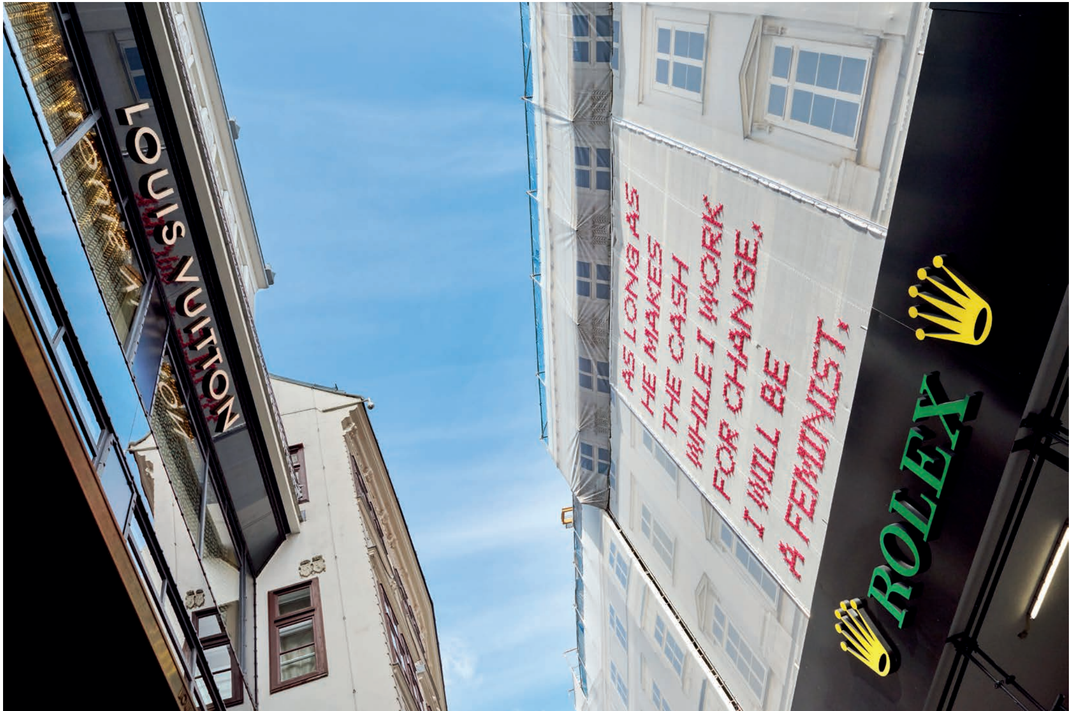
Baustelle #13: Tuchlauben 4, 1010 Wien, AT, 2020
