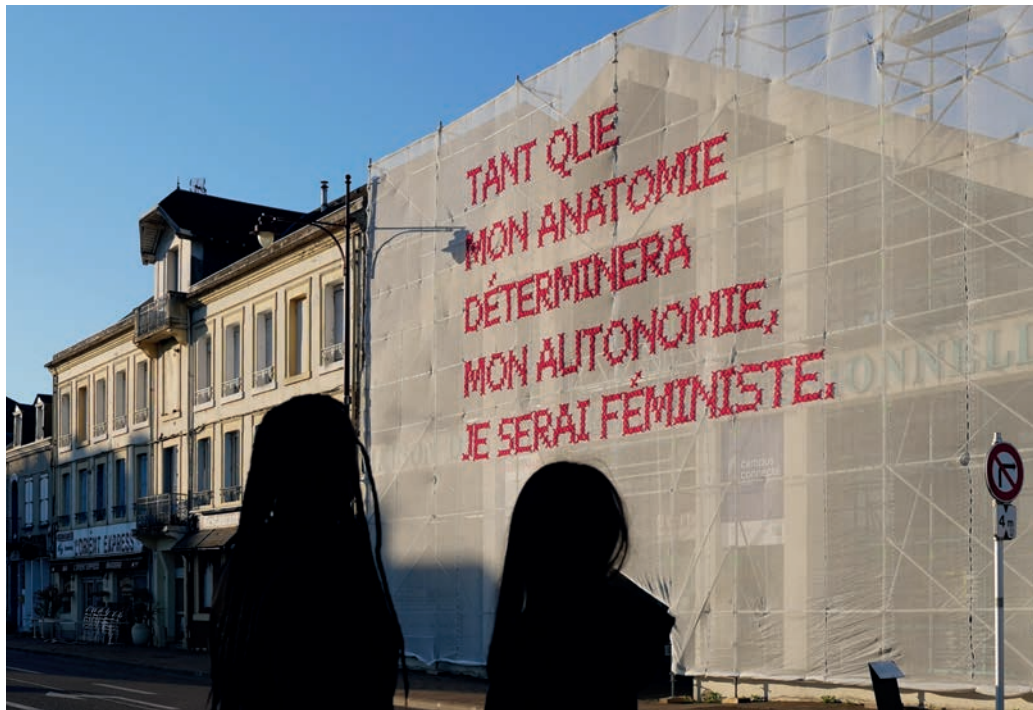
Baustelle #27: Maison des cultures professionnelles, Vierzon, FR, 2022
